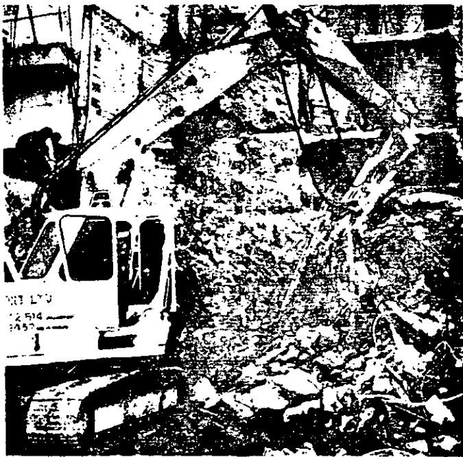
rompedor de percusión montado en una pluma.
