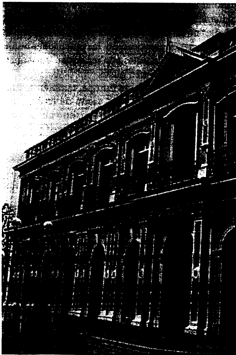
Palacio de Gobierno. Fachada este
