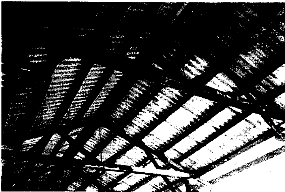
Armadura de la cubierta
