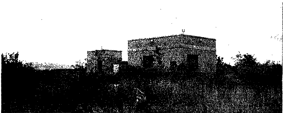
Vista de las casetas de DGSCA y sismología
