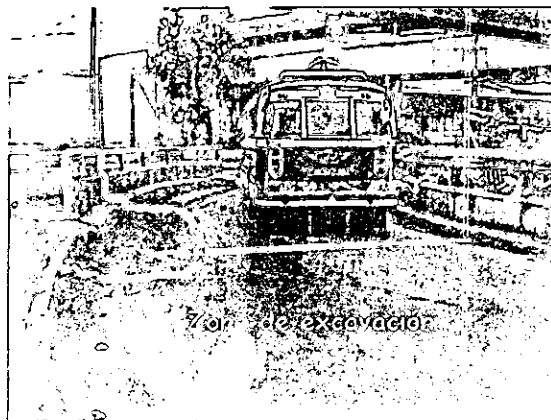
Foto 5.11 Zona donde se realizará la excavación para descubrir la corona del muro deprimido
