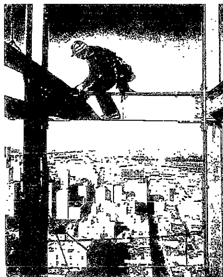
Figura 4.4.1 Montaje de estructura metálica
