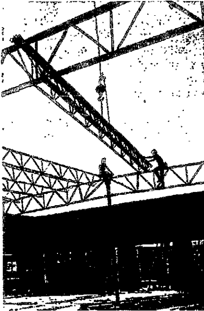
Figura 4.5.12 Izado y colocación de trabe de acero
