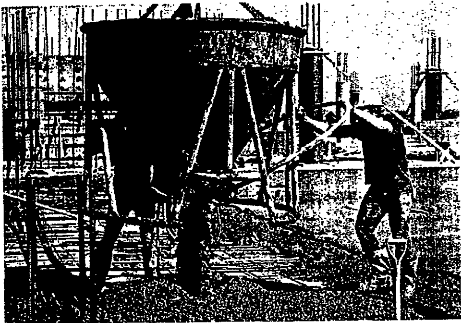
Figura 4.5.21 Colocación de concreto con tolva movida por grúa.
