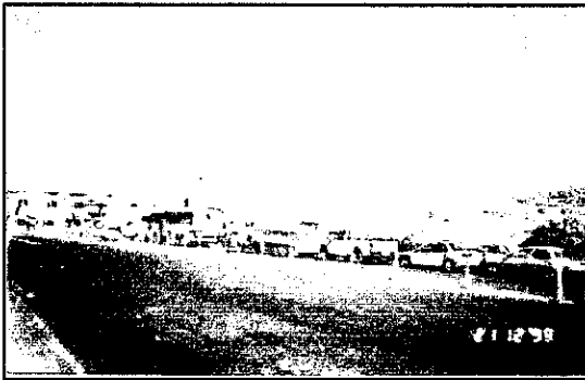
CASETA DE COBRO PLAZA PLAN DE BARRANCAS, DONDE SE OBSERVA LA CONCENTRACIÓN DE VEHÍCULOS Y EL PELIGRO QUE PUEDE REPRESENTAR QUE UN VEHÍCULO LLEGARA A QUEDARSE SIN FRENOS
