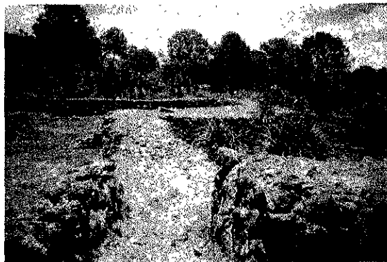
Figura 5. Calzada de carácter secundario que se conecta con la Calzada 1 y da acceso a un patio habitacional, como puede observarse esta se puede designar como una muro-calzada.
