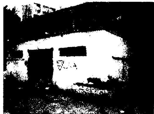
Figura 5.4. Depósito de basura en la salida a Av. Universidad
