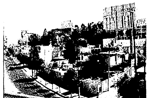
H Vivienda autoconstruida
