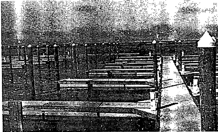
Figura 3.42 Muelle anclado con sistema de pilotes (Marinas and Small Craft Harbors, Bruce O.Tobiasson 1991).
