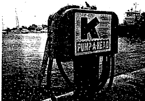
Figura 4.8 Equipo para el bombeo de aguas residuales de las embarcaciones. (Marinas and Small Craft Harbors, B.O. Tobiasson 1991).
