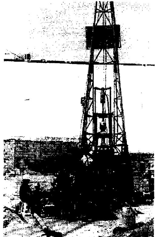
*Figura III-2, Ejecución de los sondeos.*
