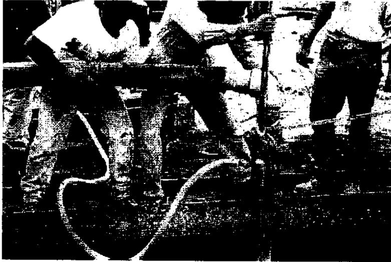
*Figura V-28, Sistema Air-lift para la limpieza del fondo de la excavación*
