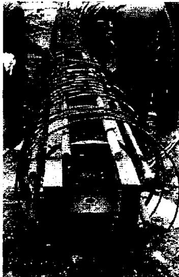
Figura VI-5, Refuerzo longitudinal de la pila P<sub>B</sub>
