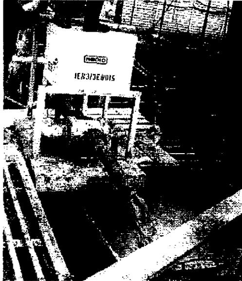
Figura V-15, Bomba para hidratación de bentonita
