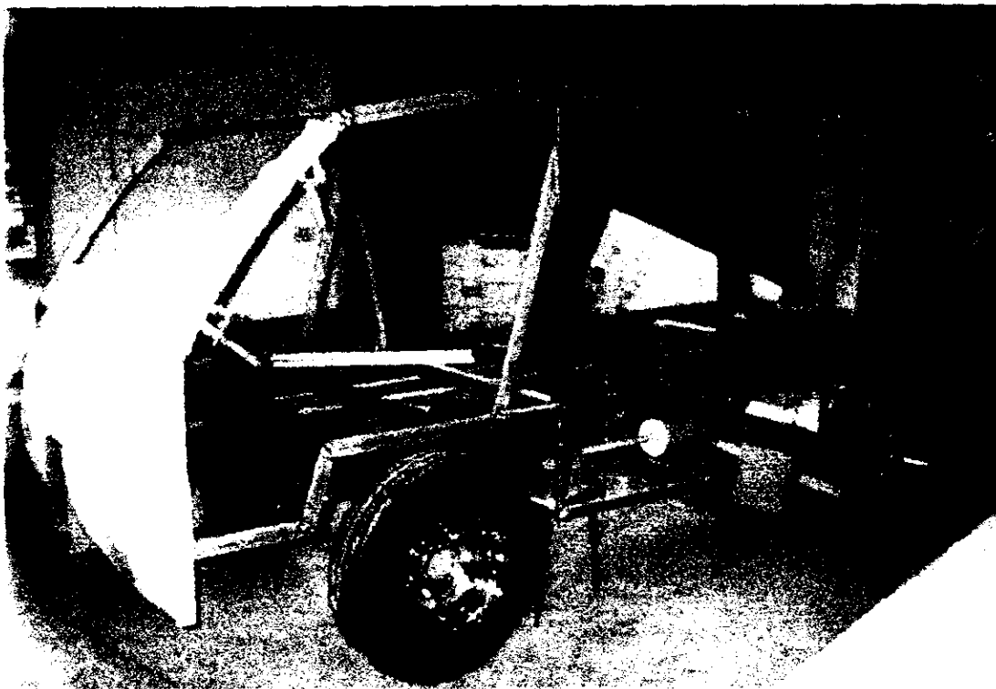
Modelado del frente del vehículo sobre la estructura planteada por el equipo de ingeniería.
