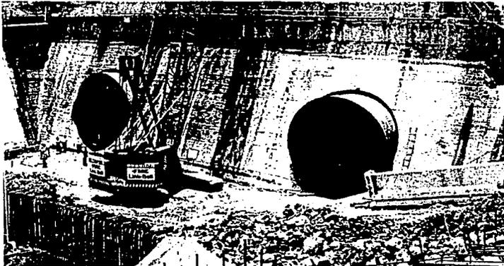
Foto 3.2. Conducción a presión, aspectos del montaje y del revestimiento metálico.
