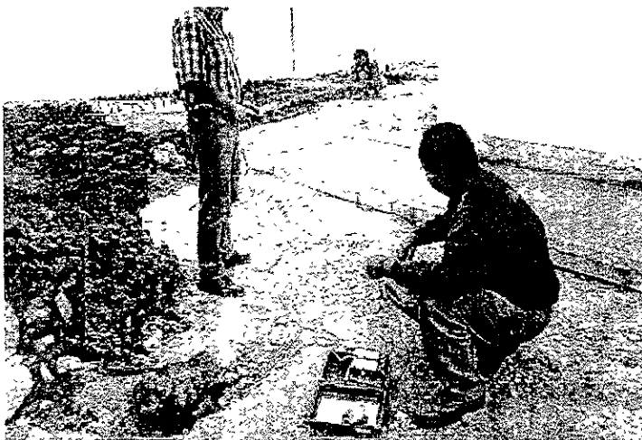
Foto 4.2 Donde se observa la realización de una prueba con megger de resistencia a tierra, para un sistema de corriente regulada
