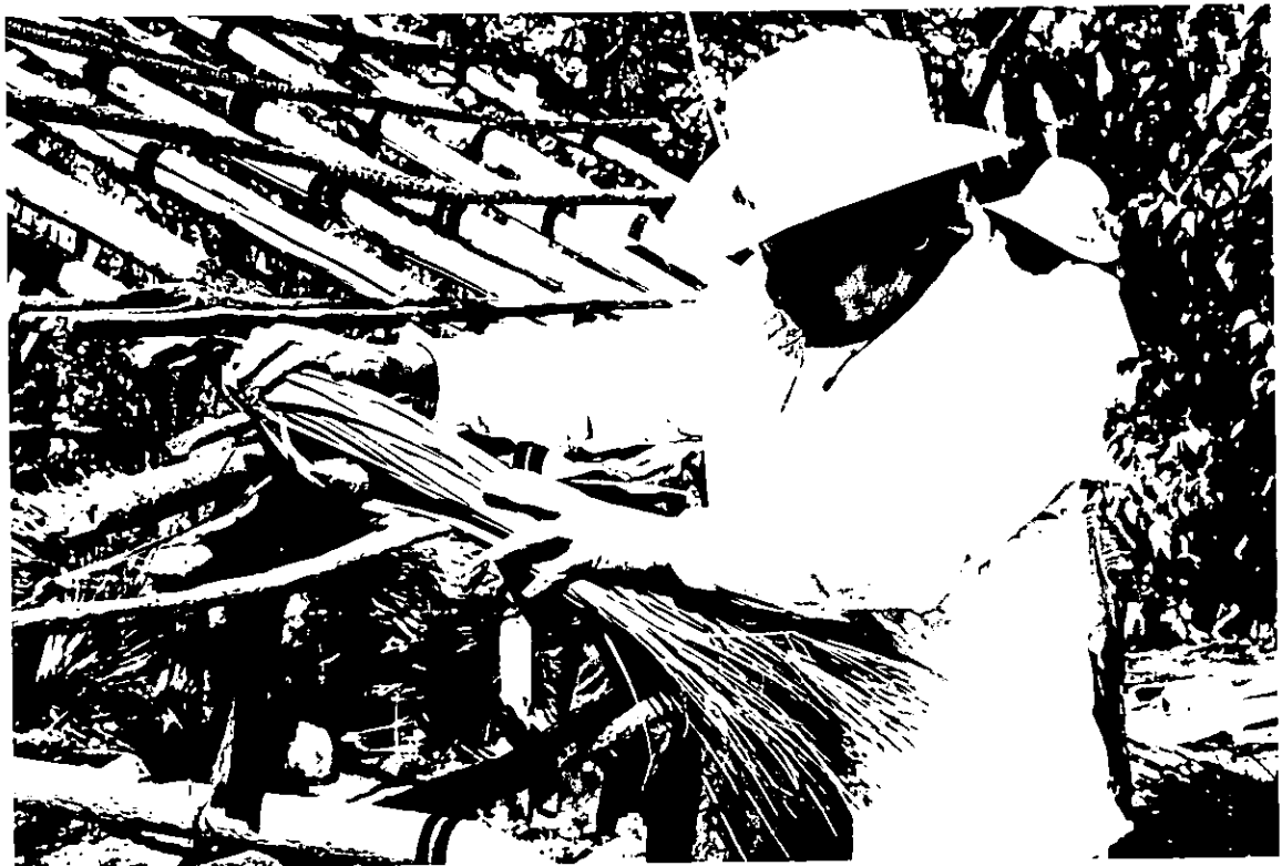
Foto 12. Colocación de los manojos de escobilla entre los travesaños del techo
