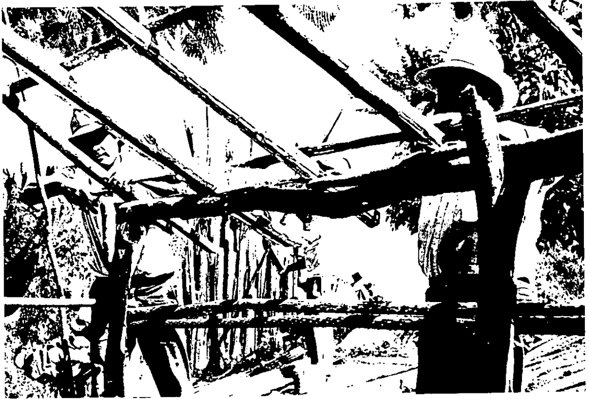
Foto 11. Armazón de la casa, con horcones y travesaños de chondato y quiotes
