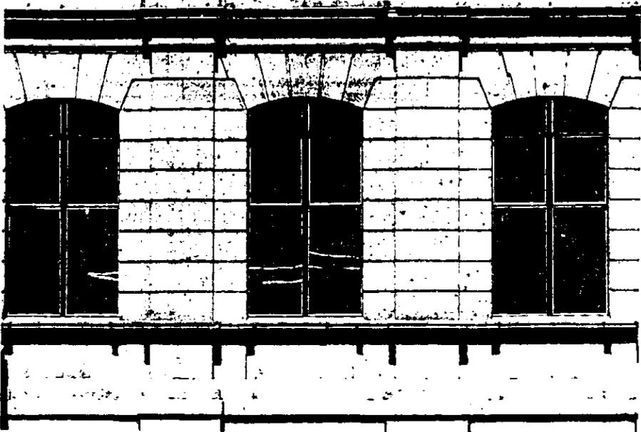
Foto 43. Vanos con arco adintelado, planta baja.
