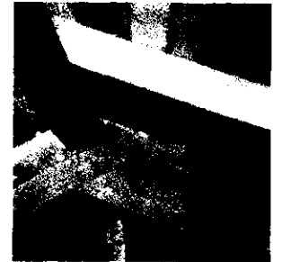
Puede verse el doble juego de largueros a dos alturas distintas y pies derechos provisionales
