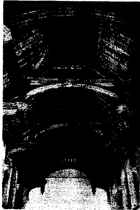
F.1 Cubierta gótica del Eltham Palace, construida en 1405, cuyo sistema de vigas horizontal o martillos apoyadas por pilares del muro se proyectan al interior para cargar el arco principal, reduciendo el claro F. de "La Madera"
