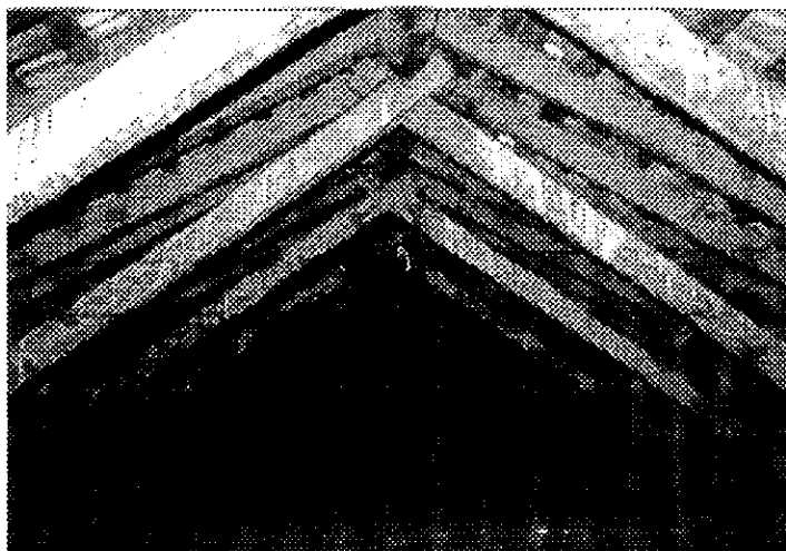
Vista del doble sistema de pares con la hilera al centro de la cubierta de Naranja F. APA. 1997
