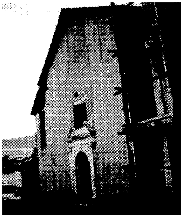
Vista actual de la fachada.
