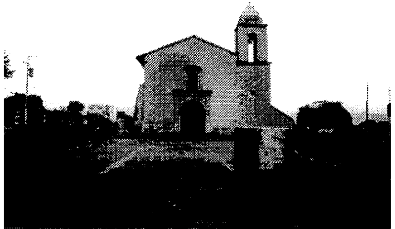
Fachada principal de la nave nueve años después de la restauración
