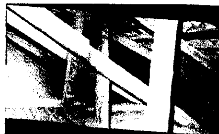
Visión de la entrada a espiga de las vigas largueras que forman el par de tijeras sobre las cuales apoya la cumbrera que sustenta el tejado: los empalmes de canes y tirantes son a media madera de igual manera se unen los pares del tejado sobre los estribos. En las fotografías inferiores se observan al centro las tijeras en el holladero y a la derecha en el tramo del artesón, en donde se refuerzan mediante pies derechos. Es interesante verificar que la mayoría de la madera está cortada con hachuela, lo que la remonta por lo menos al siglo pasado. F.15,16,17 APH. 1997
