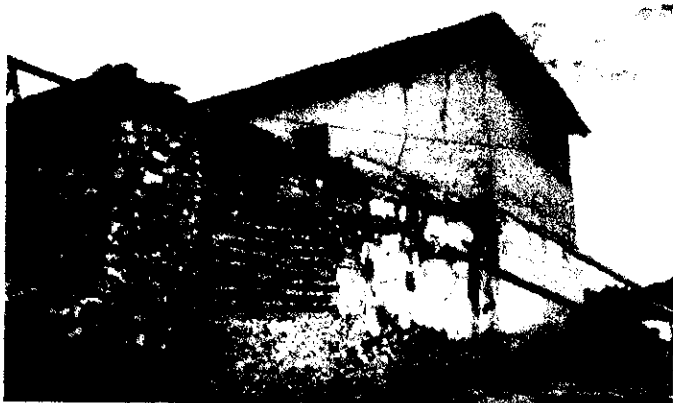
F.8 Vista posterior de los anexos de la sacristía despejados y sin el maderamen de la cubierta de medio cañón del interior que fue substituida por los vecinos por otra de madera nueva
