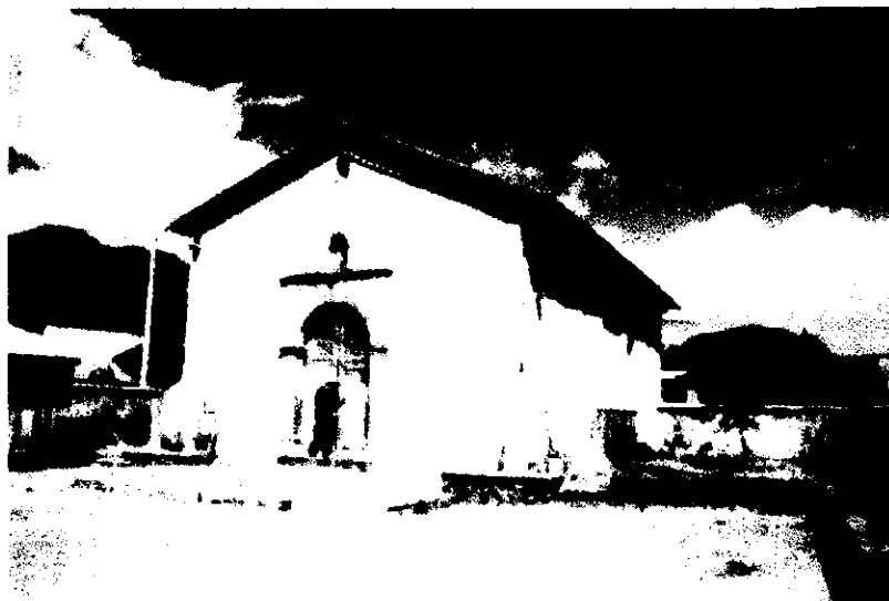
Fachada principal después de la restauración que hicimos en 1987.
