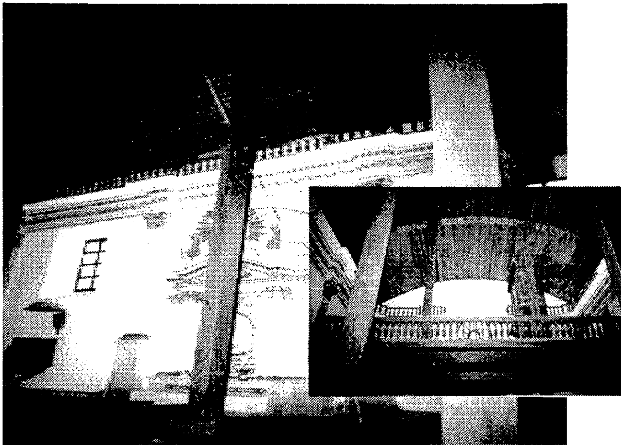
El coro, soportado por fuertes columnas coronadas por zapatas se apoyan en basas de piedra. El medio cañón remata en el testero sujetado por una ligera cercha de madera.
