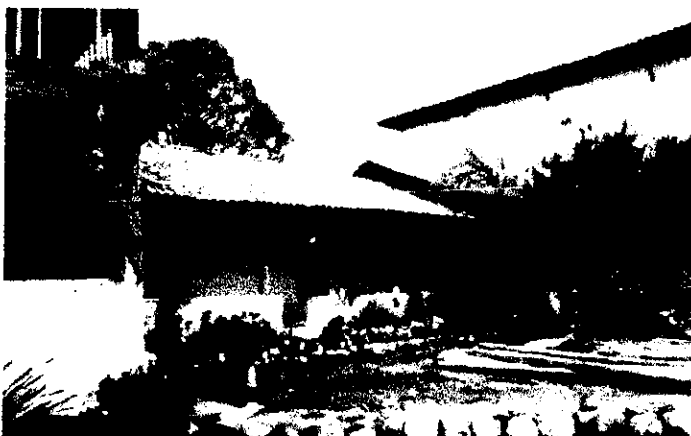
F.10 Vista del maderamen de la sacristía en proceso de desmonte, es uno de los escasos ejemplares que se cubren con cañón de tablazón y que daten del siglo XVIII, puede verse en el extremo del muro el rebaje a media madera de la viga madrina que remataba el pretil interior.
