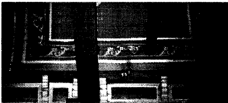
F.5 Vista de los canes que flanquean los tirantes, mientras uno de ellos atraviesa el medio cañón, otro se observa cortado en la parte inferior, como varios más a lo largo de la nave y cuya desaparición provocó el desfazamiento de los muros laterales ocasionando severos desplomes. Foto GAR.1985
