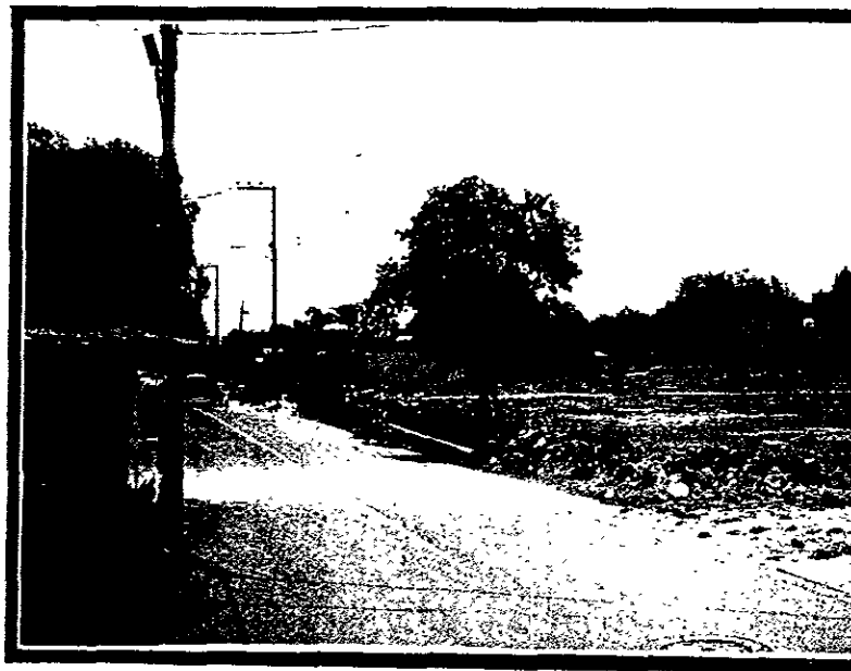
TOMA PANORAMICA DEL PF
