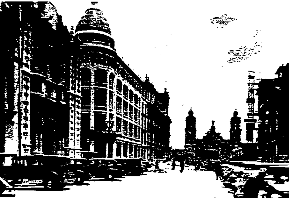
Se reinventaron fachadas hacia la nueva Avenida, la transformación fue demasiada a causa de una calle que no viene de ningún lado, y no va hacia ningún otro.
