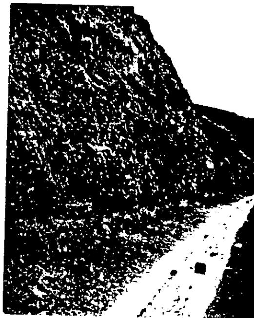
Foto III.2 Erosión en piroclastos arcillosos poco consolidados. (Sánchez, 1996-b).
