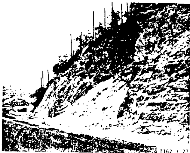
Foto III.6 Caído originado en la zona de decompresión de un corte en lutitas (Sánchez, 1996-b).
