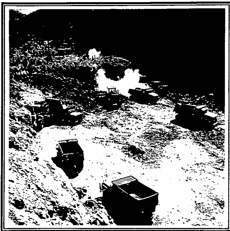
FOTO 4.5.2 Carga, acarreo y descarga del material
