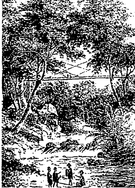
Fig. 1.2.3 Antiguo puente hecho de bambú en Borneo
