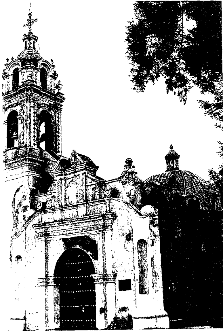
FIGURA 35. IGLESIA DEL SANTO NIÑO, INTERVENCION DE LOS DAÑOS EN LA TORRE Y FACHADA DE LA IGLESIA, RESANES.
