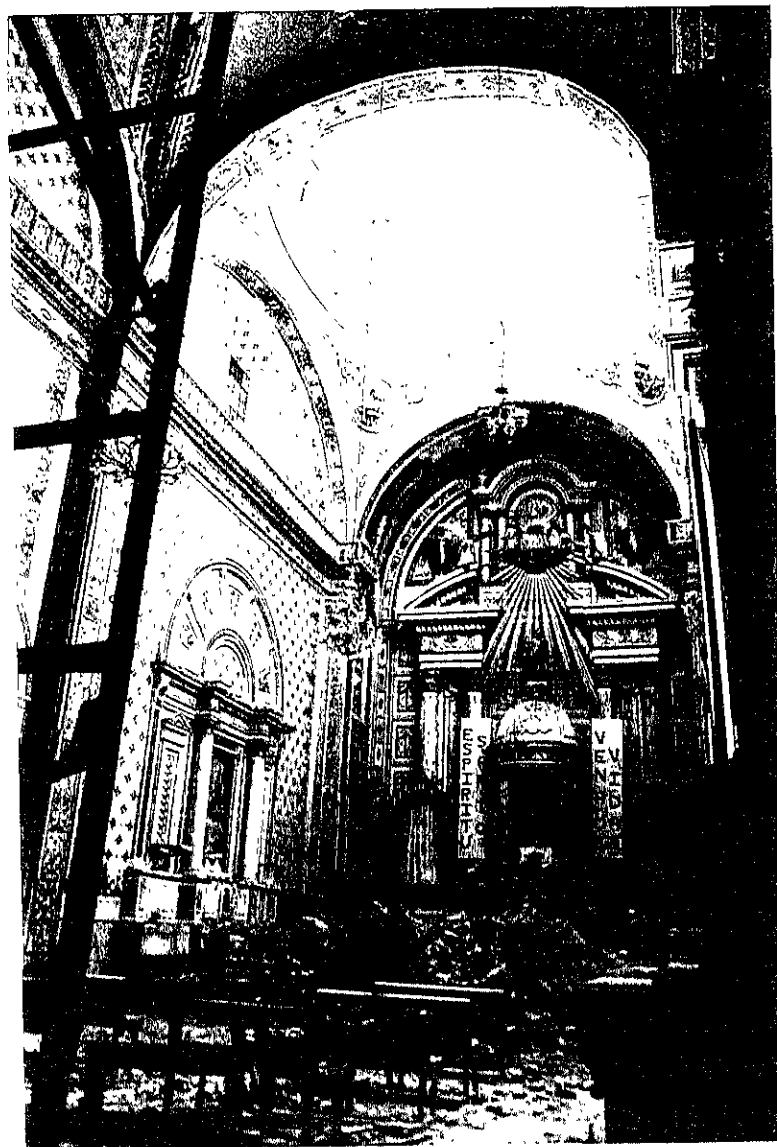
FIGURA 28. PARROQUIA DE SAN ANDRES, DAÑOS DE LA CUPULA PRINCIPAL.
