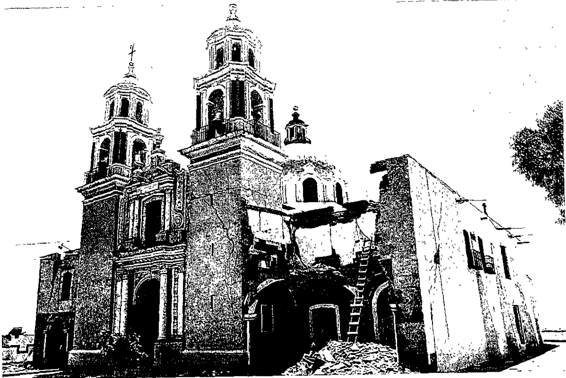
FIGURA 31. SANTIUARIO DE LOS MEDIOS, DAÑOS EN EL CUERPO Y LA FACHADA.
