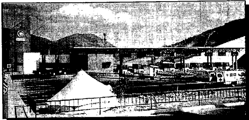
Caseta de cobro: Tramo Tierra Colorada - Acapulco
