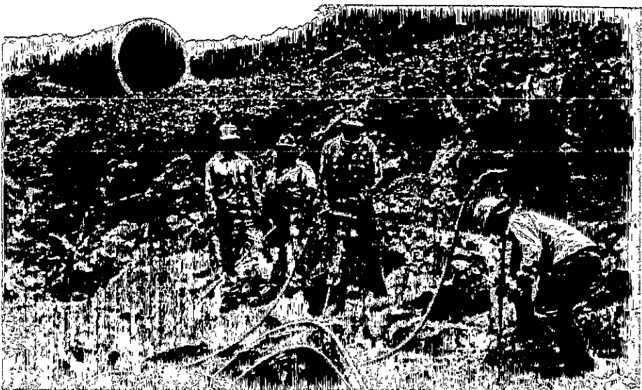
Peforistas en actividad de barrenación para el uso de explosivos en la excavación del tajo de acceso en la derivación 3-A.
