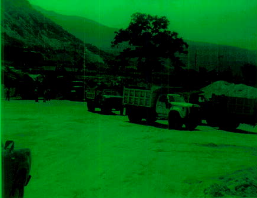
FOTO 10 MOVIMIENTO DE TIERRA DE CORTES A TERRAPLENES
