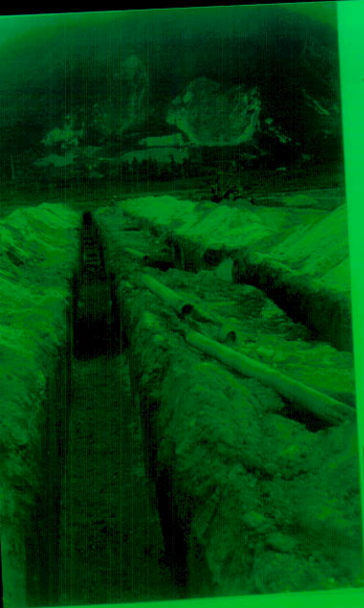
FOTO 54 EXCAVACION Y TENDIDO PARA INSTALACION HIDRAULICA
