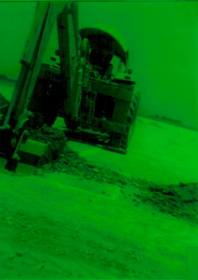
FOTO 14 EXCAVACION DE ZAPATAS ←
