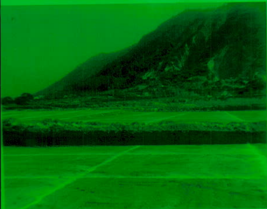
FOTO 11 TRAZO DE EJES EN PLATAFORMAS CONFORMADAS
