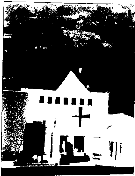
● Vista de la Fachada Principal y detalle de Acceso Peatonal.
