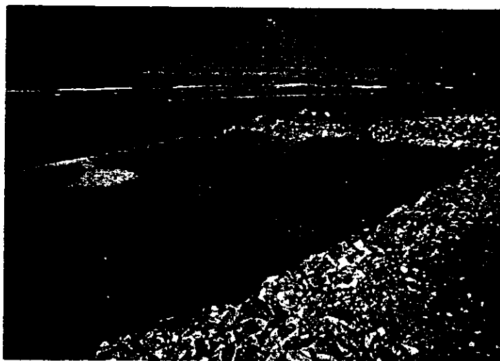
FOTO 5. Espigones de enrocamiento con carrocerías de automóvil en su extremo. La zona fué protegida de emergencia. Se presenta el corrimiento que sufre el río y la isla que se empieza a formar, por lo que los espigones ya no están en contacto con el flujo.
