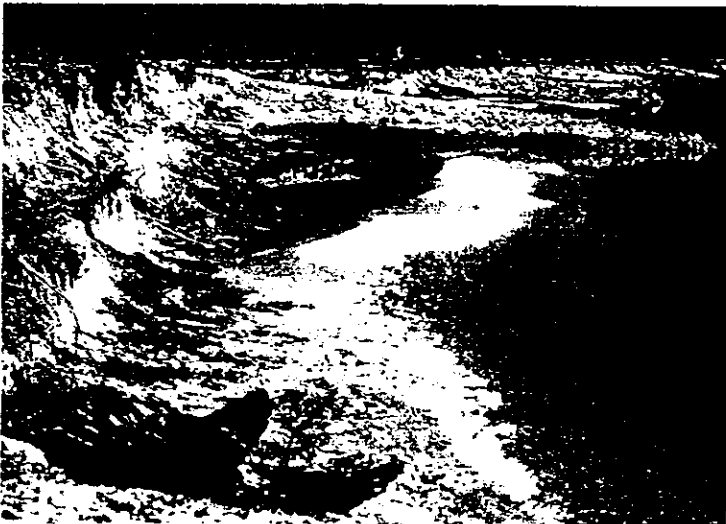
FOTO 7. Se muestran espigones empotrados. Se aprecia la trinchera que fué excavada y posteriormente rellena con enrocamiento.
