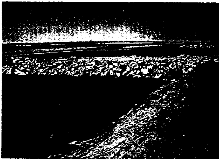
FOTO 5. Espigones de enrocamiento con carrocerías de automóvil en su extremo. La zona fué protegida de emergencia. Se presenta el corrimiento que sufre el río y la isla que se empieza a formar, por lo que los espigones ya no están en contacto con el flujo.
