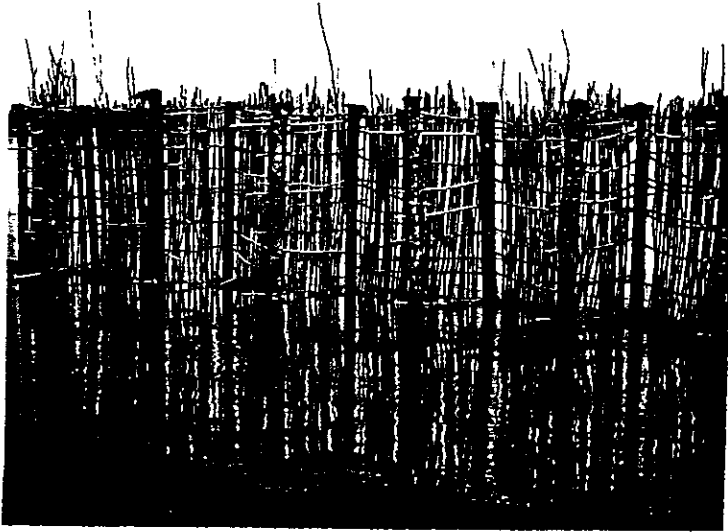
FOTO 15. Espigón permeable construido con troncos de palmera y ramas. Estos espigones son fácilmente destruidos por los troncos que arrastra la corriente.
