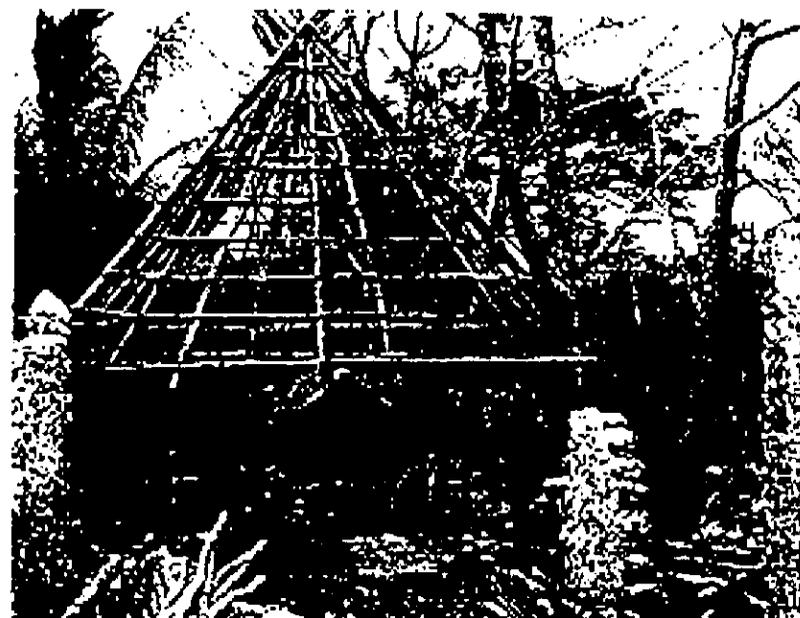
Fig. 4.3.3. Detalle de armado de techo cónico.
