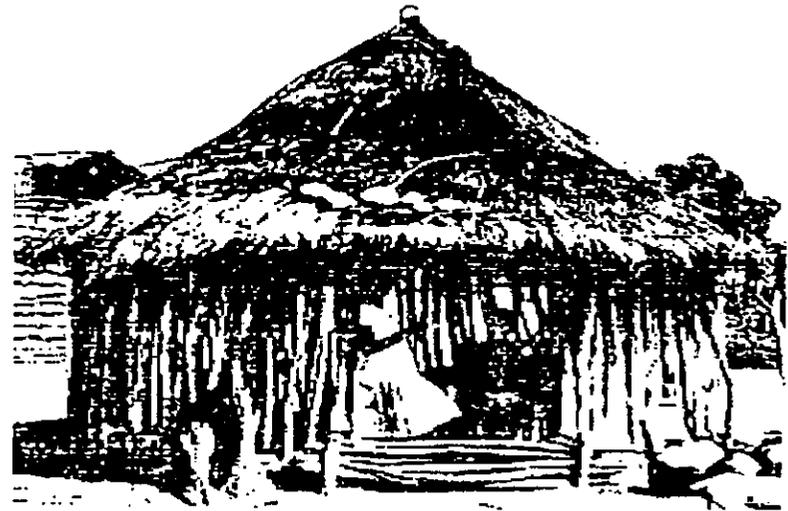
Fig. 5.2.8. Vivienda de planta circular con muros de varas. Foto: SAHOP, 1978
