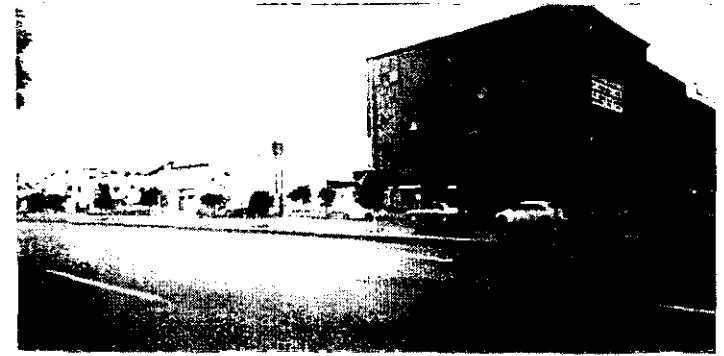
Foto # 3. En la foto el edificio más alto que se aprecia es un cine a una cuadra del terreno.
