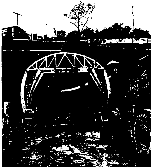
Foto 5.21. Cimbra metálica para el revestimiento del túnel.
