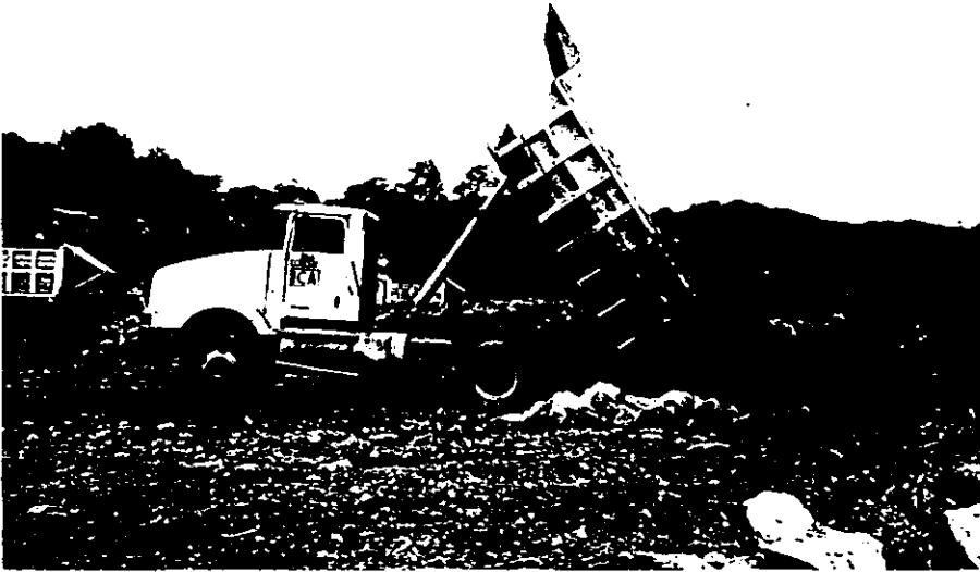
Foto 3.5 Movimiento de tierras.
