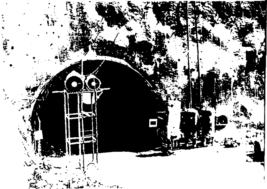
Foto 5.8. Ventilación del túnel.
