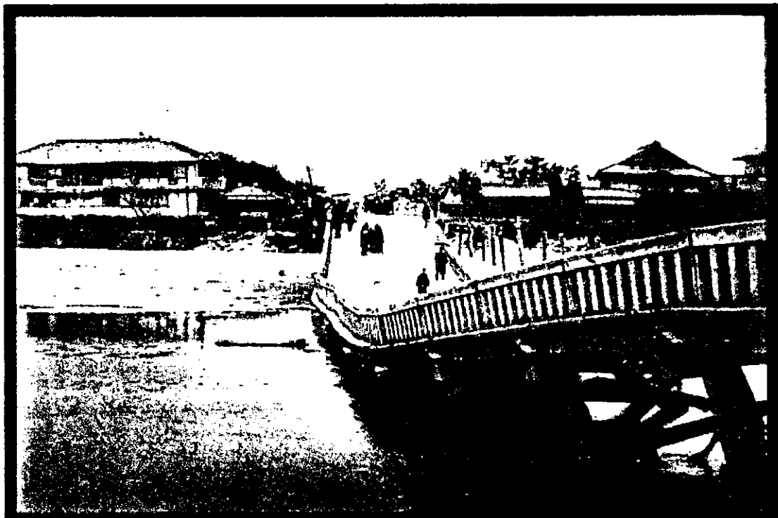
Fig A.1. Puente Biwajima. Gran terremoto de Japón, Mino Owari, 1891. (EERC)
