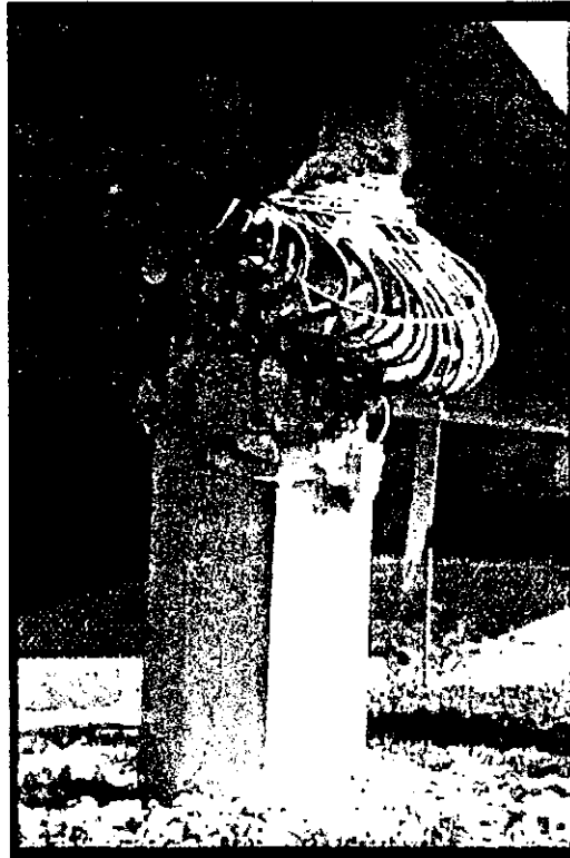
Fig A.10. Pandeo del refuerzo longitudinal por debajo de la zona confinada. Puente Bull Creek Canyon. Terremoto de Northridge, 1994 (EERC).
