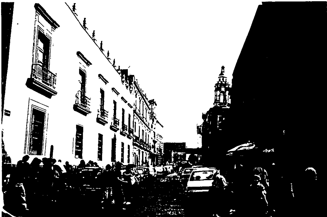
Conjunto de la Calle Lic. Primo Verdad
