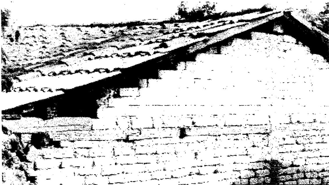
f.25.- Detalle del asentamiento de la cubierta sobre los muros
