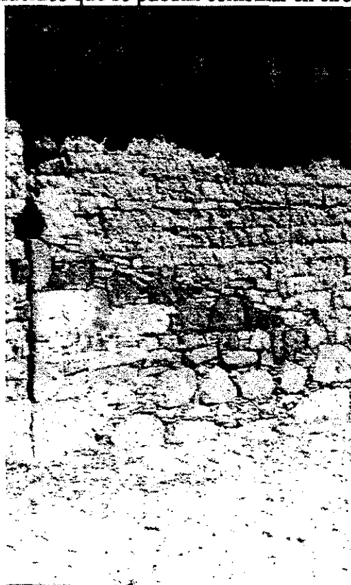
f.22 y f.23.- Triangulaciones de refuerzo en esquinas de las casas.
