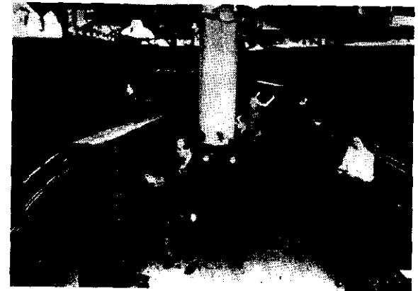
La Eniac (1945) máquina antecesora de lo que hoy conocemos como computadoras, se manejaba por medio de múltiples conexiones de cables.
