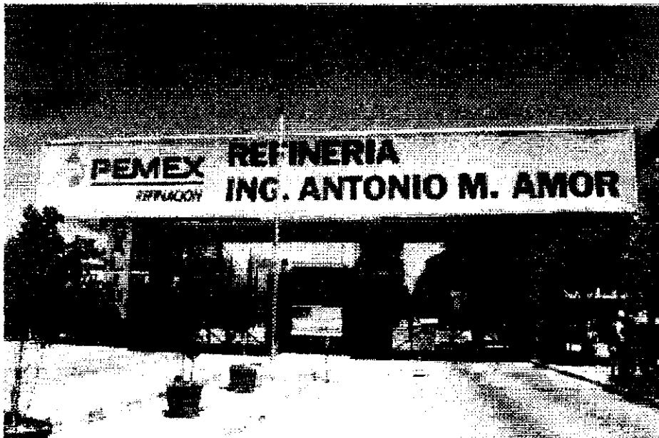
Puerta 1 de la Refinería "Ing. Antonio M. Amor" 7
