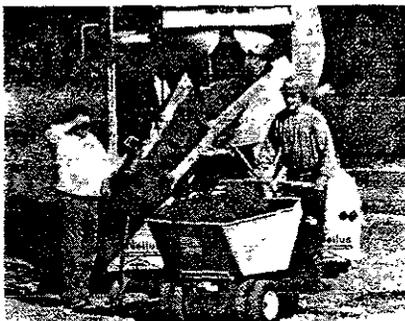
Fig. 7-1. Carretilla motorizada puede mover el concreto a lo largo de distancias cortas.
