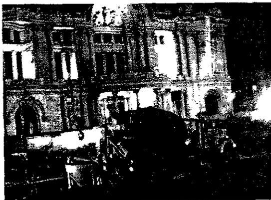
Fig. 7-3 Camión mezclador de descarga trasera, por medio de un canalón, construcción estacionamiento Bellas Artes.
