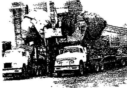
Fig. 5-3. Mezclado central en mezcladores estacionarios del tipo de tambor basculante.
