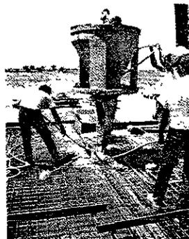
Fig. 7-2 Cucharón ó comúnmente llamada Bacha, el concreto puede elevarse con la ayuda de una grúa.
