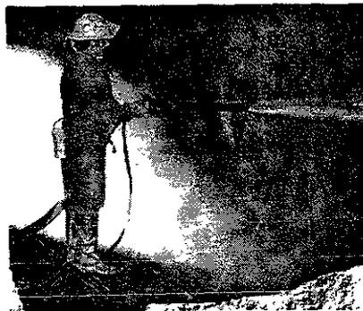
Fig. 7-6. Concreto lanzado, su uso es aplicado generalmente para estabilizar paredes o taludes.
