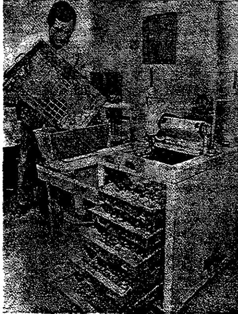
FIG. 3-5. Granulometría de agregado grueso en el laboratorio.
