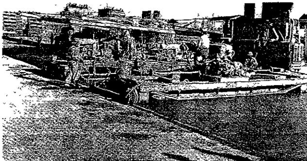
Fig. 7-18 Vibrador de llana en forma mecánica, extendedora y de acabado, se usa en pavimentación de gran volumen.
