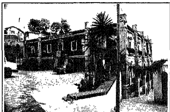
Estado actual del Palacio Municipal
