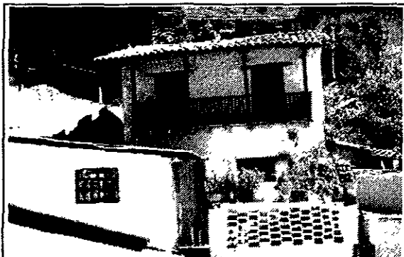
Casa en buen estado de mantenimiento, que se puede mejorar con simples modificaciones.
