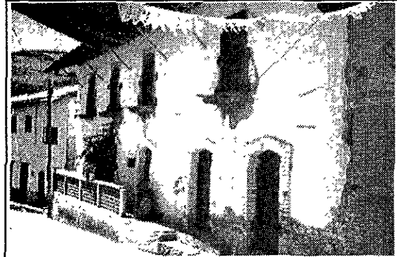
Nótese cómo los barandales de los balcones han sido arrancados y el edificio se haya en un doloroso abandono.
