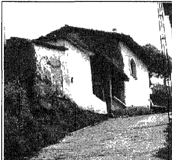
Casa del Barrio de San José
