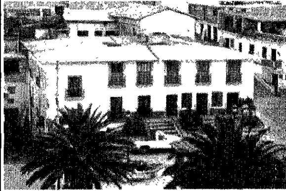
La casa tiene ahora un segundo nivel (aunque no ganó mucho en altura aprovechando el espacio ganado por el desnivel del techo anterior y la generosa altura del nivel anterior). Afortunadamente se respetaron las proporciones de los vanos y el estilo de éstos. Los barandales son de los que se removieron al kiosco porfiriano. Se techó con losa inclinada de concreto (dejando las varillas salidas!!!)
