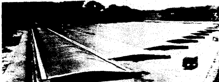
Instalaciones de destilación canadiense en Haití (en 1969, con recubrimiento de vidrio) y en la isla del Caribe San Vicente (en 1970, con recubrimiento de hojas de PVC). Funcionan como las del año 1872.
