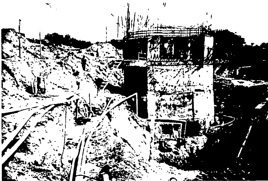
EXCAVACION CANAL DE LLAMADA ( CARCAMO DE BOMBEO EN EL RIO BRAVO )
