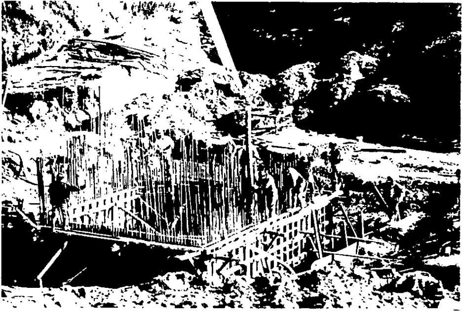
SUMINISTRO Y COLOCACION DEL CONCRETO
