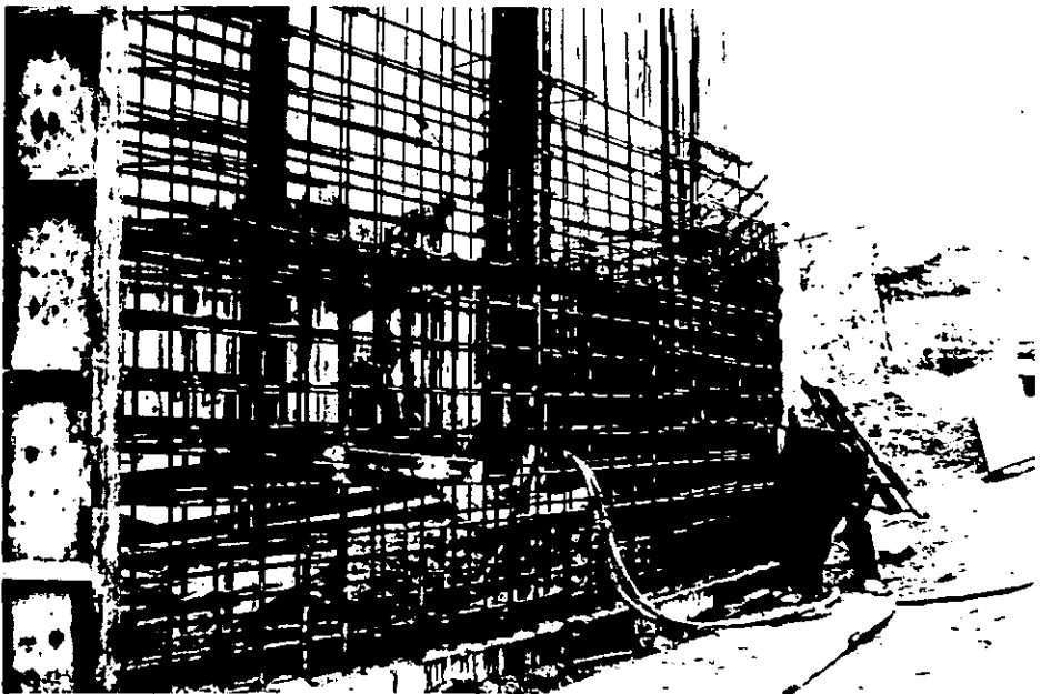
( CARCAMO DE BOMBEO EN EL RIO BRAVO )
