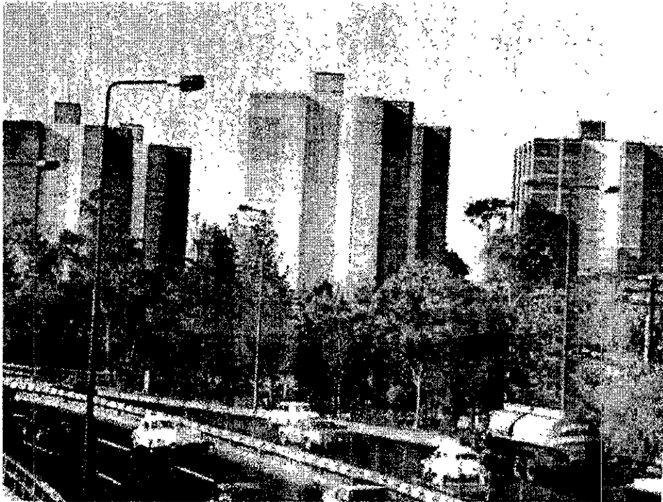
VISTA GENERAL DEL CONJUNTO.
