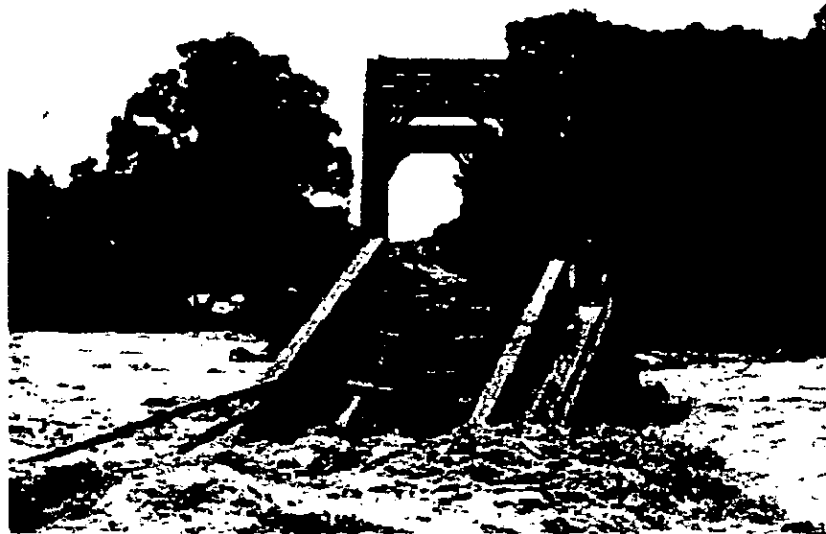
La caídas del puente, cerca de Tapachula, después de fuertes lluvias en Chiapas el 10 de septiembre de 1998.
