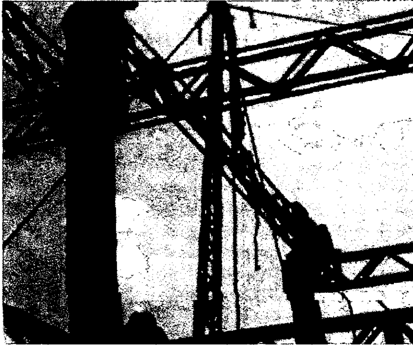
Montaje de una armadura por el centro.
