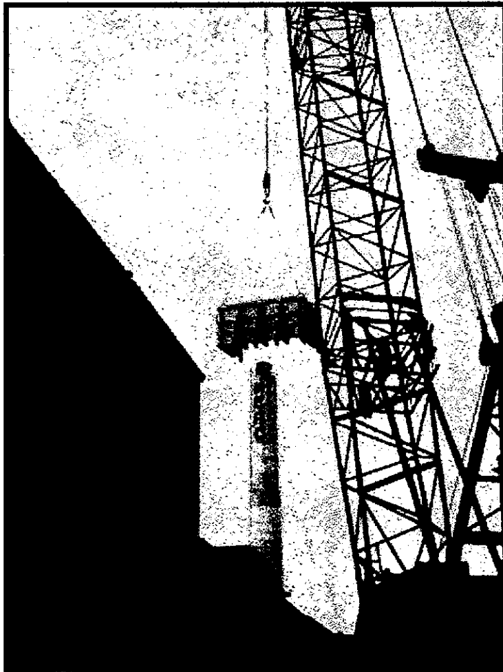
Una grúa coloca en obra los elementos que conformaran la estructura
