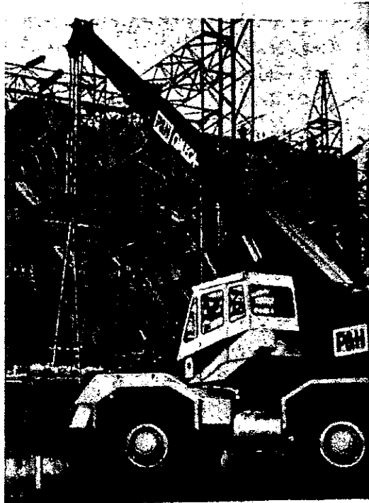
Montaje de una armadura.
