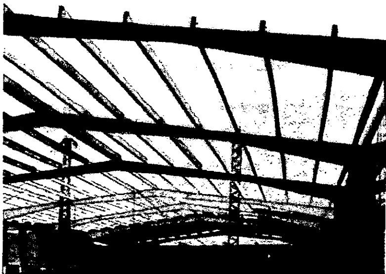
Montaje de una armadura por los extremos.
