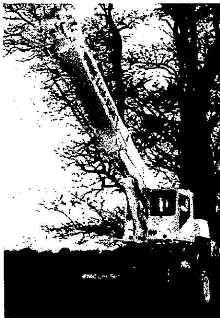
Grúa montada en camión
