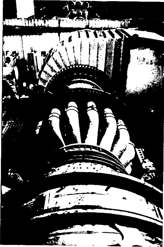
Fig. 5.51 Turbina de gas U-2 en mantenimiento mayor.
