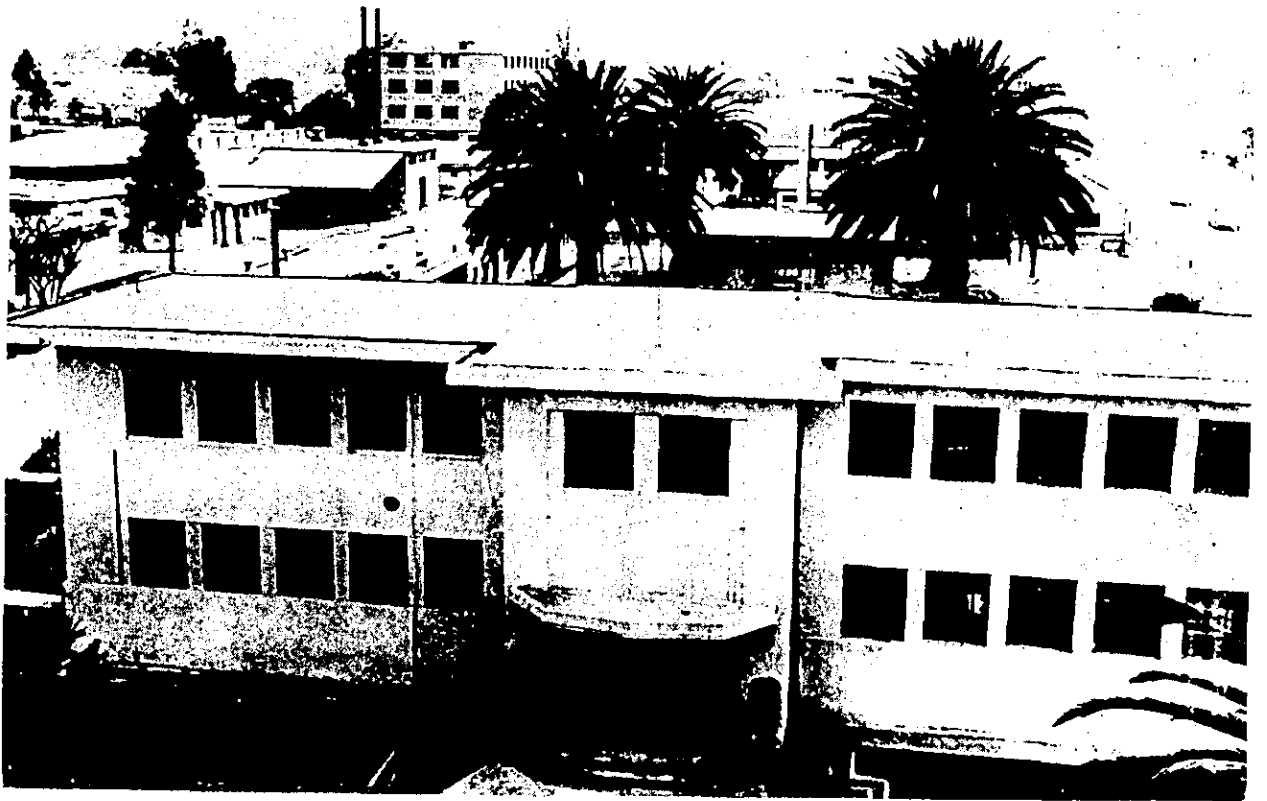
Instituto Nacional de Higiene. Salas de descanso y comedor en la planta baja. Taller de vidriería en la planta alta; izq.: al fondo, la granja.
