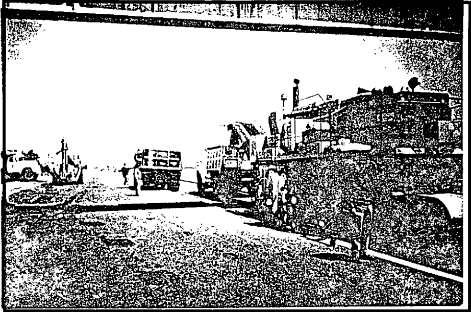
CORTE EN FRIO DE LA CARPETA ASFALTICA CON EQUIPO ROTO-MILL
