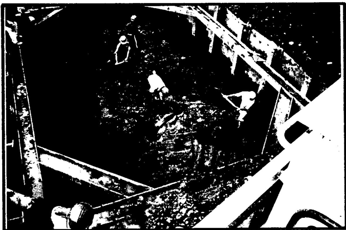
**Hincado de viguetas para evitar desplazamientos de la tubería al realizar la excavación.**
