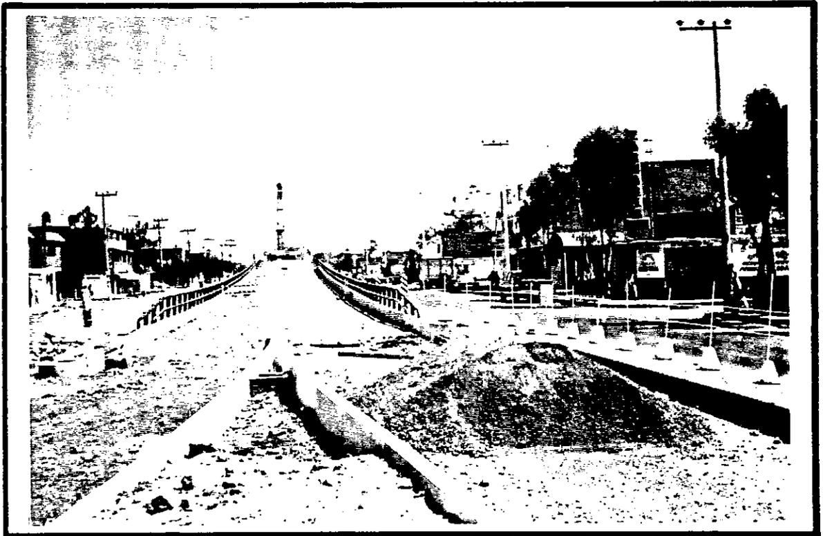
Ya que se tienen construidos los muros laterales y el muro estribo, se debiera excavar toda el área que ocupara el terraplén de acceso a 1.80 mts. y a 0.50 mts. bajo el nivel de terreno natural junto al estribo y donde da inicio el terraplén respectivamente. La excavación se realizara en una sola etapa y con equipo ligero, en caso de existir rellenos no controlados, deberan retirarse en su totalidad ver fig. ( 5 ).
