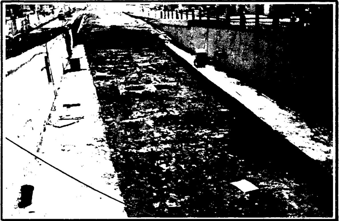
El fondo de la excavación se escarificara a una profundidad de 15 cm., retirando cualquier material que pudiera ser nocivo al comportamiento del terraplén, como materia orgánica, materiales con excesiva humedad y consistencia muy blanda, cascajo y fragmentos líticos mayores de 4", etc.
