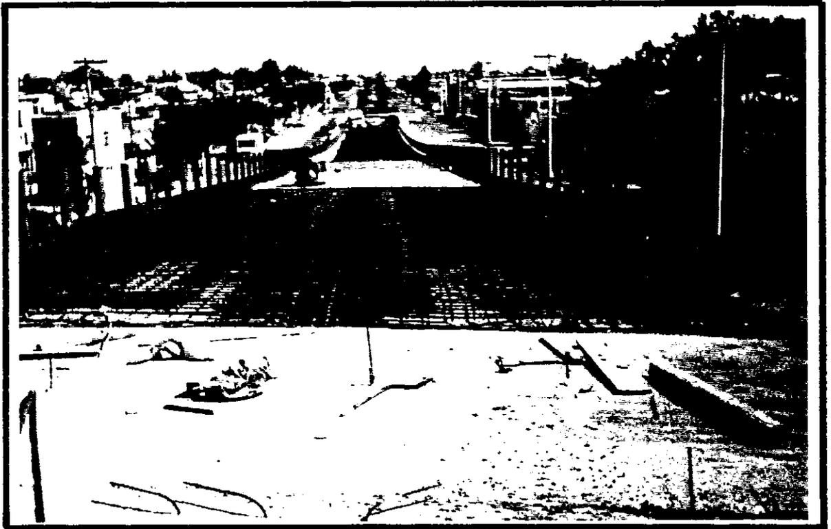
**Sentido de avance en el montaje de travespartes partiendo de las rampas de acceso, y en dirección hacia el claro central.**
