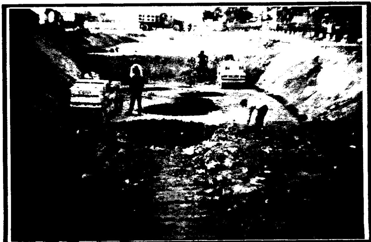
**Retiro de tubería existente en caja de flexión con equipo mecánico
