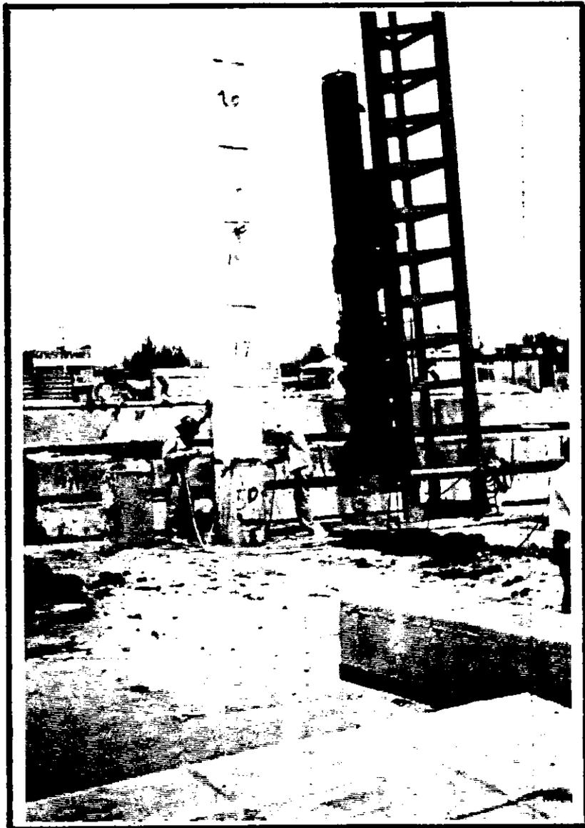
Ya que se tiene hincada la segunda parte del pilote hasta el nivel de terreno natural, se efectuara un sobre hincado por medio de un dispositivo de control que se adapta al martillo y posteriormente se acopla al pilote, esto con la finalidad de hincar los pilotes al nivel establecido en proyecto.
