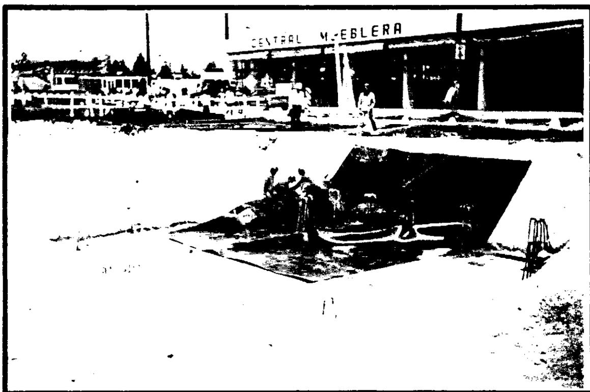
Para verificar su impermeabilidad y eficiencia, se hará una prueba de estanquidad al concluir los trabajos correspondientes a la construcción del cajón de cimentación.
