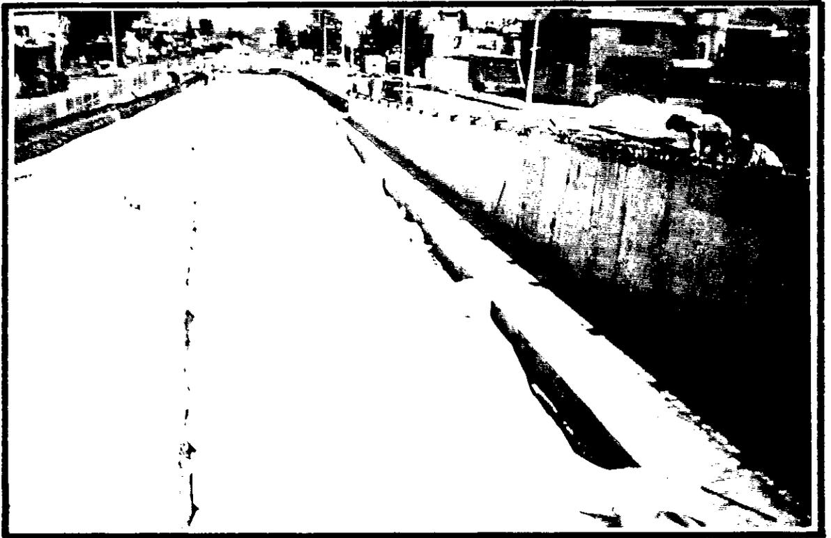
Ya que se tiene colocada la membrana geotextil en la zona del terraplén, se procederá a colocar un relleno aligerado (tezontlé) en capas de 50 cm. máximo en todo el ancho del terraplén hasta alcanzar el nivel de desplante de la capa sub-base del pavimento.
