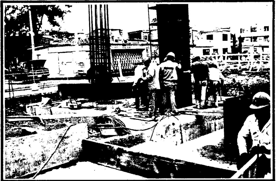
Cabe señalar que la colocación de cimbra en columnas de poca altura se hace por medios manuales, cuando la altura ya es considerable se recurre a medios mecánicos, como patos ó gruas para su izaje y colocación.
