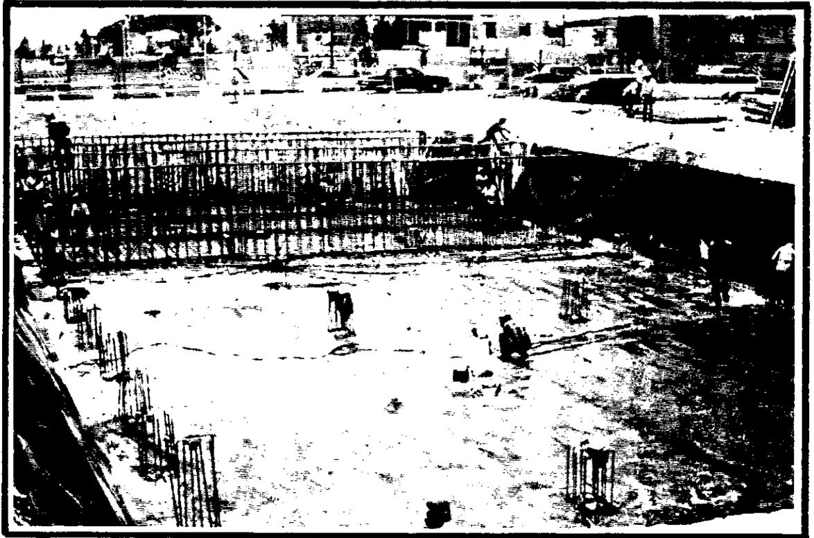
Durante la etapa de armado de la losa de fondo y contratrabes, se verificara la posición y separación correcta del acero, esta se realizara físicamente, es decir con el plano estructural correspondiente al cajón de cimentación, se checaran los elementos que lo integran. Dichos elementos deben estar armados y separados como se indica en proyecto.
