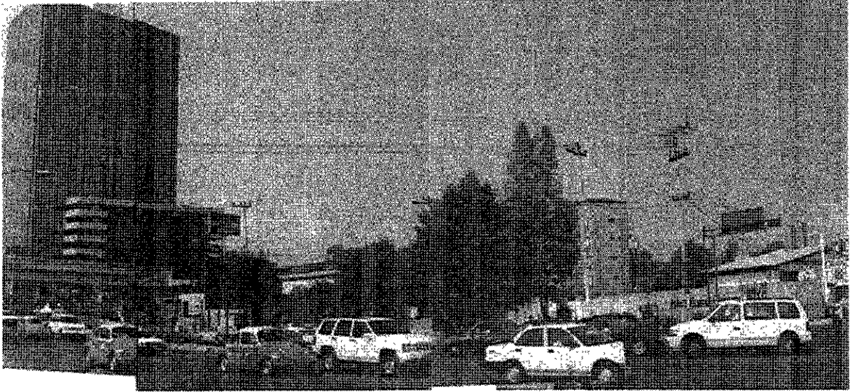
FOTO 16. Vista General del terreno. Teniendo a la izquierda el Edificio de Teléfonos de México. Este terreno es de un gran valor ya que esta rodeado por tres Avenidas importantes como son: Río Churubusco, Coyoacán y Universidad.
