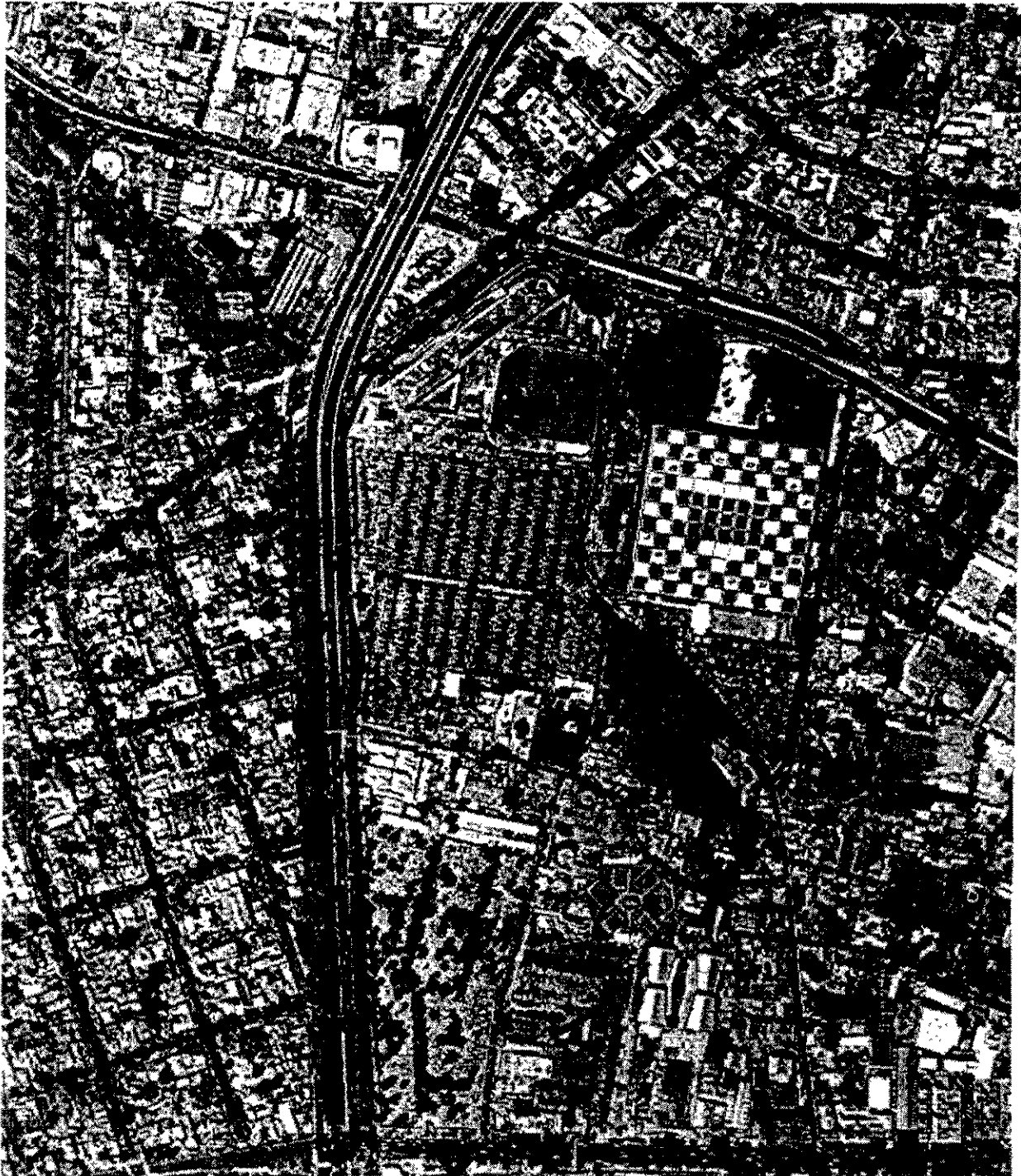
FOTO 1. Vista aérea de la Zona de Estudio.
