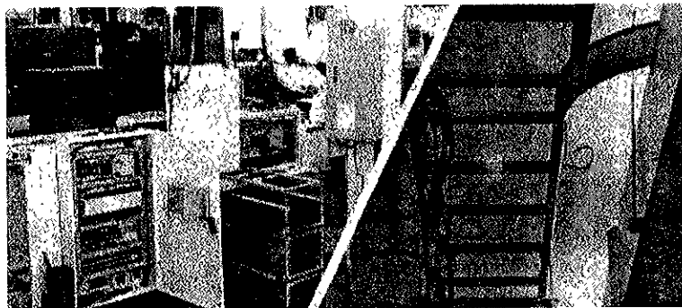
Figura 3.12. ALAMBRADO DE GABINETES DE CONTROL PARA UN PROCESO INDUSTRIAL
