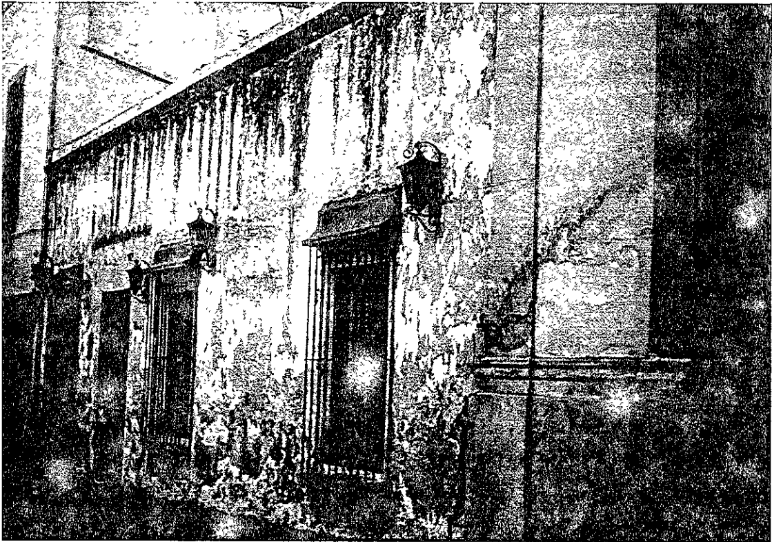
Casa con fachada del siglo XIX en una de las calles del centro de la Ciudad de Cuernavaca.
