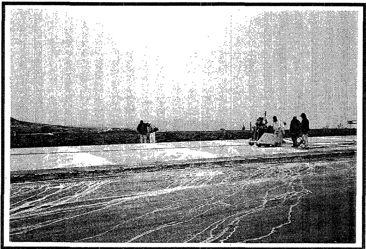
Figura 7.16 Construcción de las juntas mediante corte con disco abrasivo.
