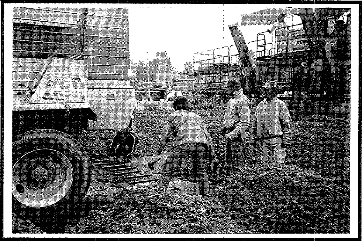
Figura 7.5 En esta fotografía se observa la colocación manual de las canastillas con las pasajuntas, antes del vertido de la mezcla de concreto sobre la superficie.
