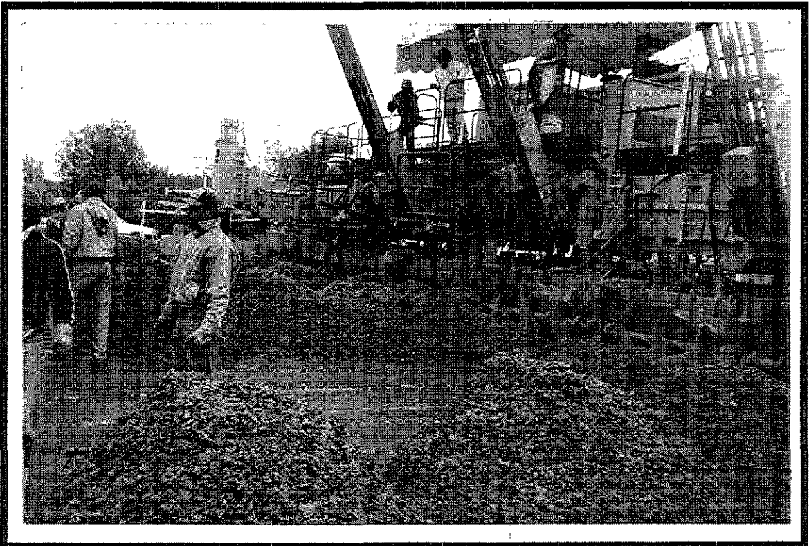
Figura 7.9 Pavimentadora de concreto hidráulico autopropulsada, con cimbra deslizante integrada y para anchos hasta de 20 metros. La barra sin fin extiende el concreto en toda la superficie.
